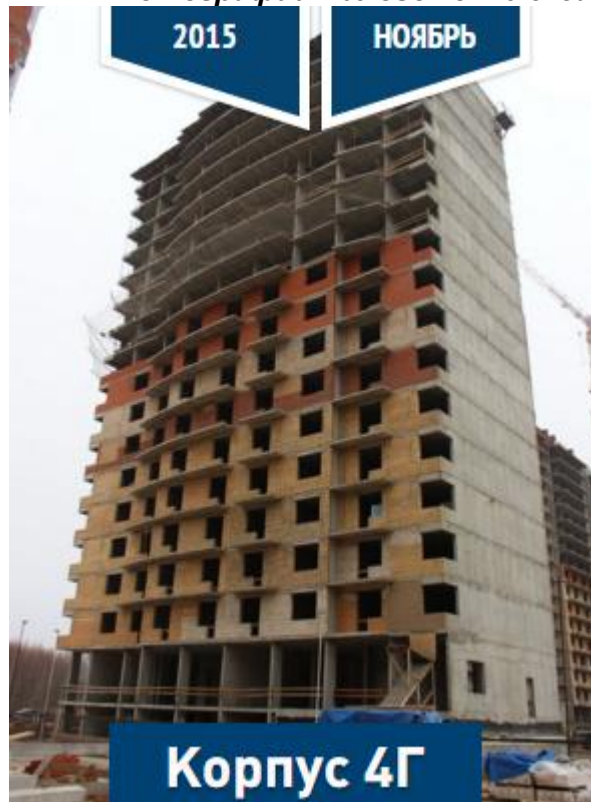
Фото 1. Ход строительства жилого дома по строительному адресу: Московская область, г. Мытищи, микрорайон № 17-А, участок 44 по схеме межевания
