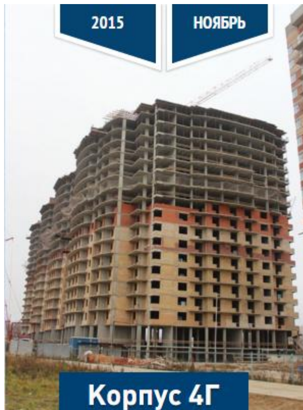
Фото 3. Ход строительства жилого дома по строительному адресу: Московская область, г. Мытищи, микрорайон № 17-А, участок 44 по схеме межевания 1
