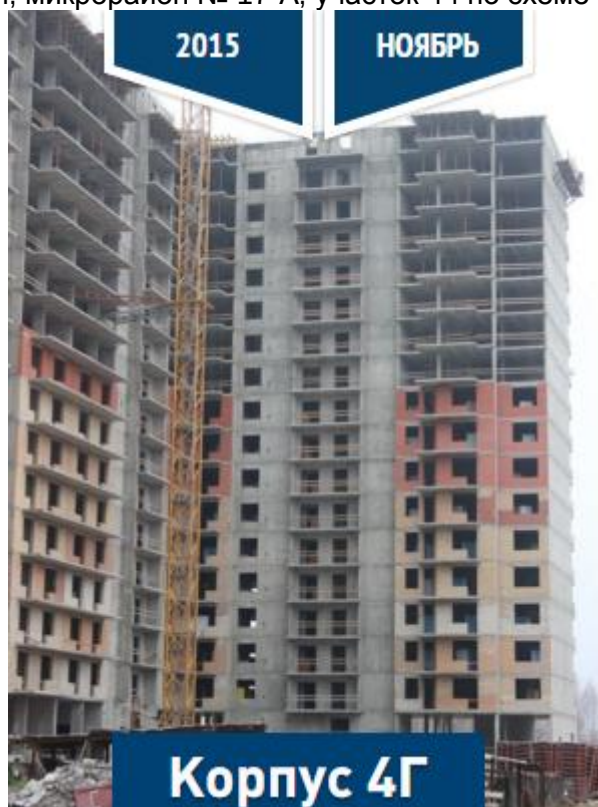
Фото 2. Ход строительства жилого дома по строительному адресу: Московская область, г. Мытищи, микрорайон № 17-А, участок 44 по схеме межевания
